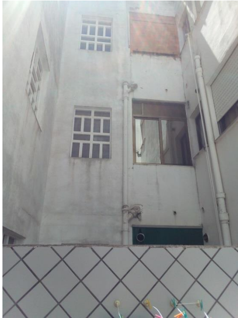
Fotografía 3: Vista del patio interior donde está prevista la instalación del ascensor
