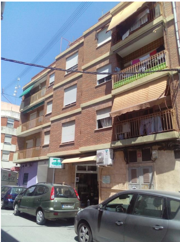
Fotografía 2: Vista de la fachada del edificio
