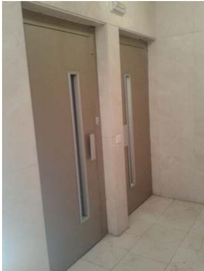
Ilustración 1: Actual entrada ascensor
