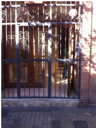
Ilustración 3: Actual escalón de entrada al zaguán
