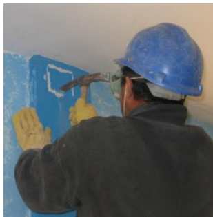
Imagen 46 Apertura de cata de fachada próxima a pilar y/o forjado
