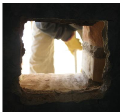
Imagen 44 Apertura de cata de fachada
