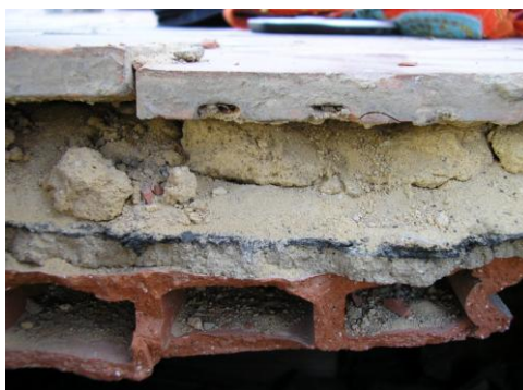
Imagen 48 Identificación de materiales en cata de cubierta plana
