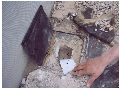
Imagen 47 Apertura de cata de cubierta plana
