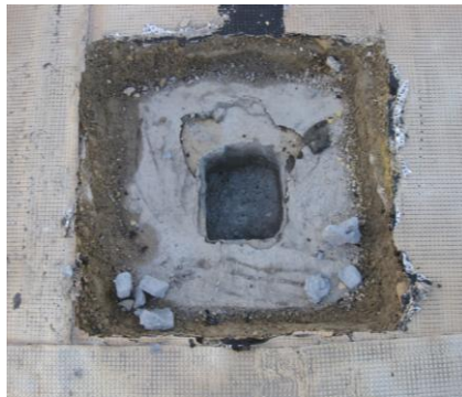
Imagen 47 Apertura de cata de cubierta plana
