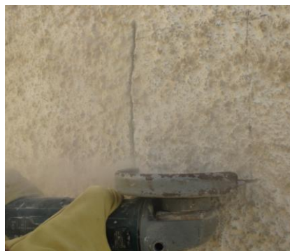
Imagen 43 Marcado y corte mediante disco de cata de fachada
