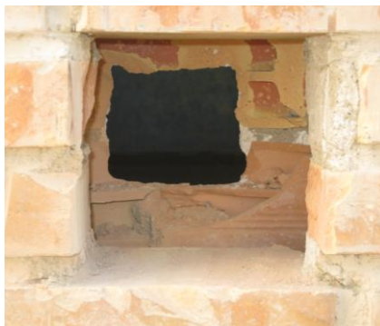
Imagen 45 Apertura de cata de fachada
