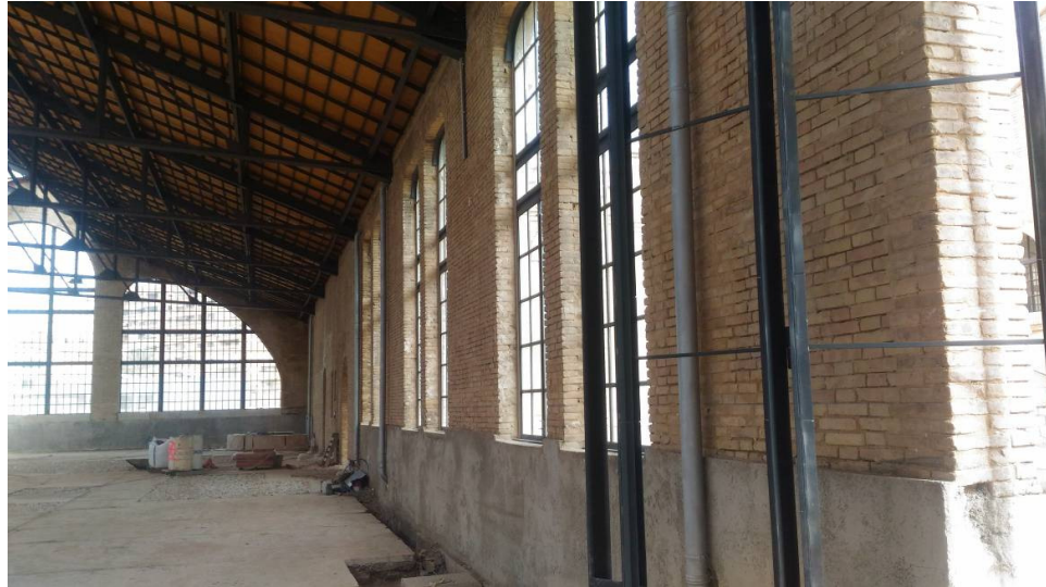
Imagen del estado actual de la cubierta y las carpinterías metálicas
