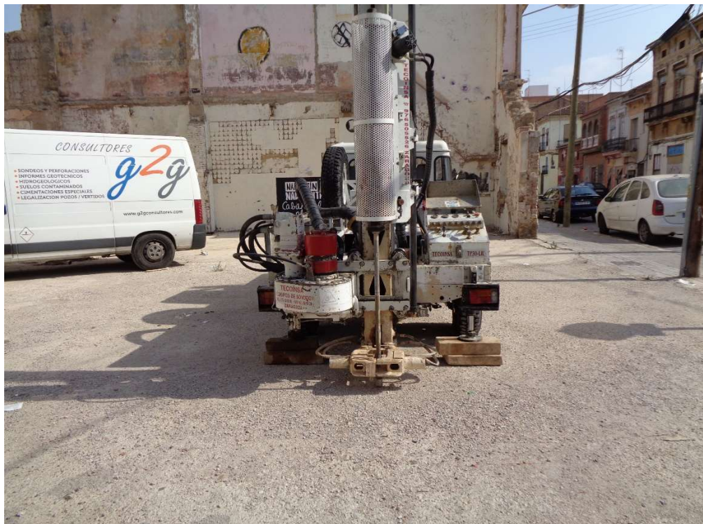
Foto 4. Emplazamiento y desarrollo del ensayo DPSH n° 2
