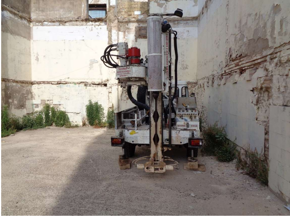
Foto 3. Emplazamiento y desarrollo del ensayo DPSH n°1
