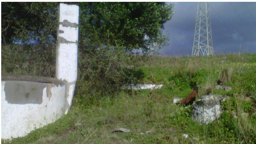
Foto 2 del extremo oeste de la parcela mostrando construcción que protege a pozo con agua a unos 2,70 m de la superficie (según medida del 23 feb 2012). Foto 3 (abajo) mostrando cortijo en ruinas existente hacia el sur de la parcela.
