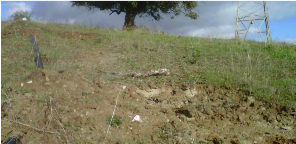
Foto 1: Detalle de la zona noroeste de la actuación mostrando suelos residuales arcillolimosos. Al fondo torre de alta tensión al norte de la cual parecen ubicarse conducción de agua de gran diámetro.
