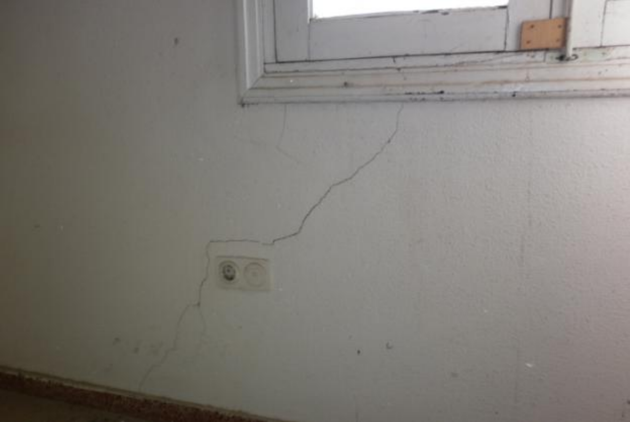
Fisura en punto CM.11 que manifiesta el cedimiento del cargadero oeste del patio.
