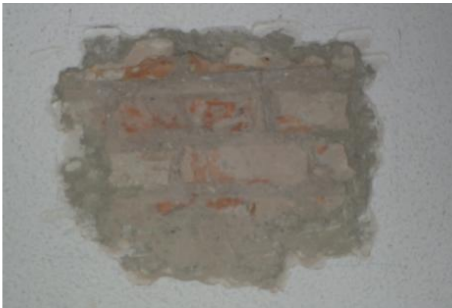
Cata CM.2B en cara interior de muro interior.
