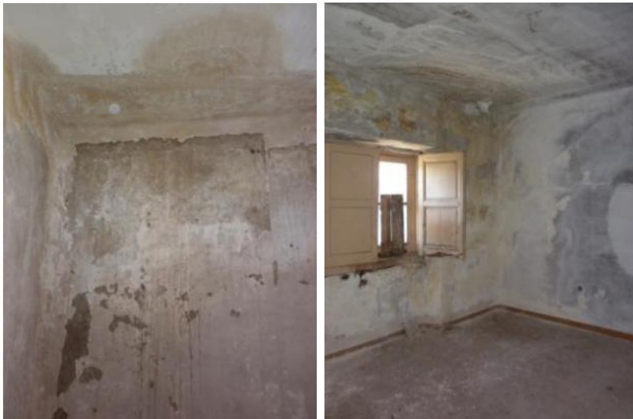
Distintos paramentos afectados por la entrada de agua
