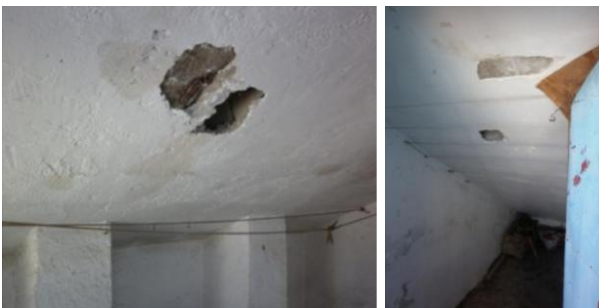
Catas CT.1C y CT.2C en el forjado inclinado en la zona de trasteros
