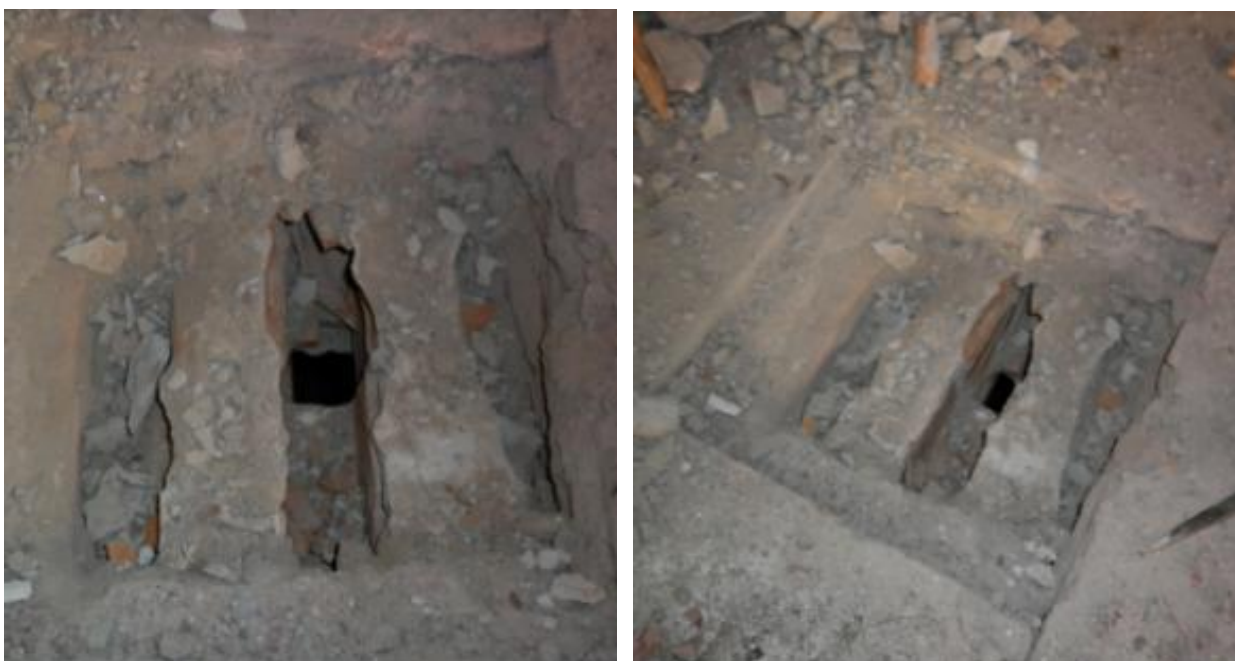
Cata CS.31 en forjado cerámico
