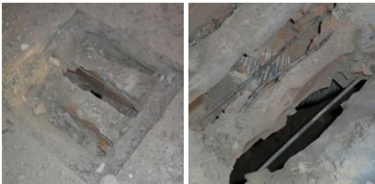
Cata nº 1 en forjado cerámico
