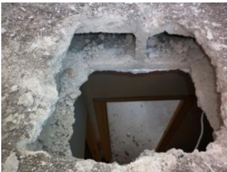
Cata n.º 3 en forjado de hormigón
