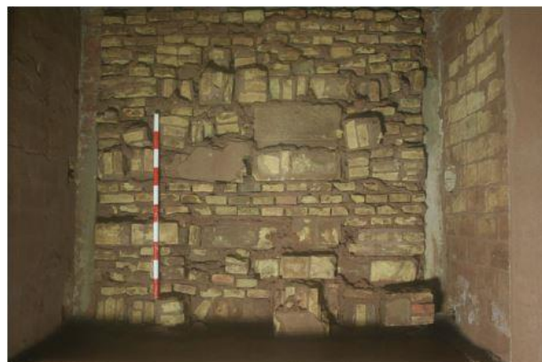
Tapiado acceso Plaza El Soñador
