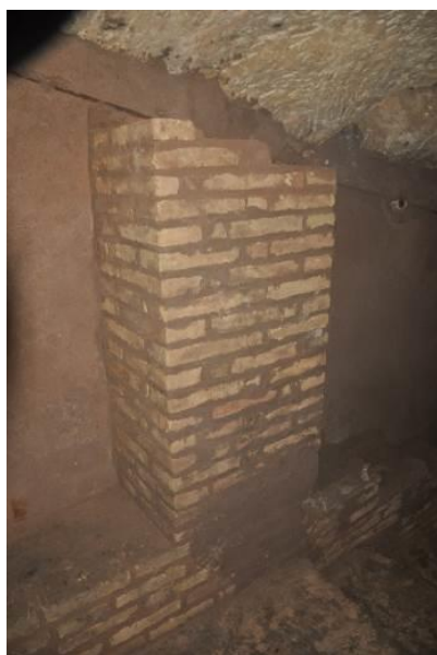
Columna de ventilación (V4).
