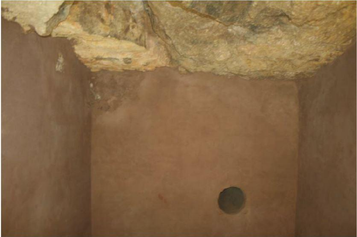
Sala de máquinas (V2)
