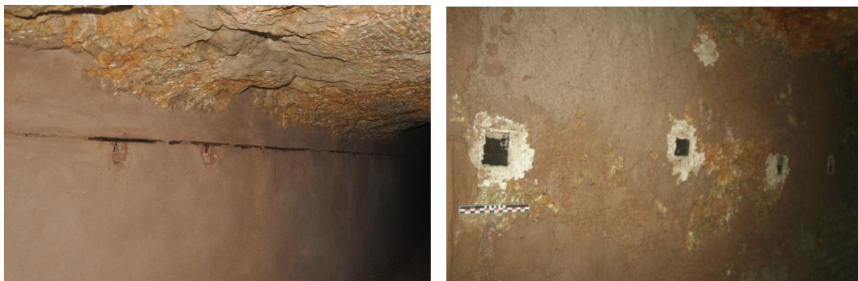
Restos de tendido eléctrico conservados de forma desigual a lo largo del refugio.
