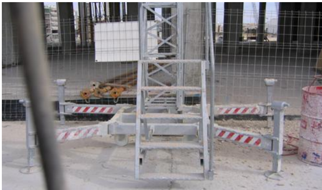
Detalle de acceso a la plataforma
