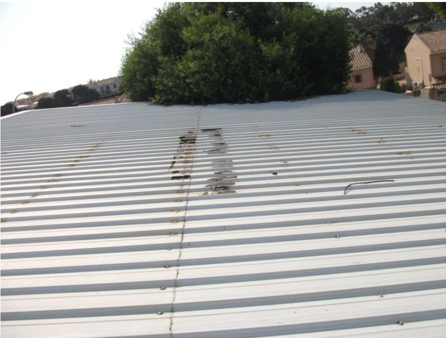
VISTA GENERAL DE LA CUBIERTA DEL EDIFICIO DE GIMNASIO DEL C.P. ROMUALDO BALLESTER
