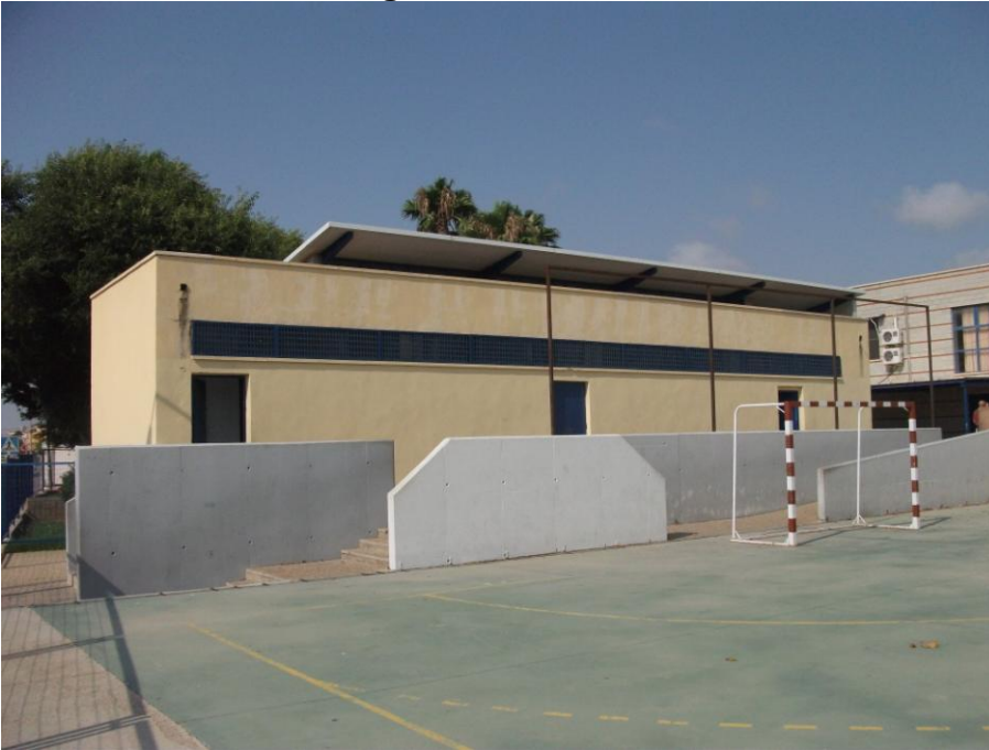
VISTA GENERAL DEL EDIFICIO DE GIMNASIO DEL C.P. ROMUALDO BALLESTER
