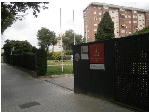
Figura 1 Acceso exterior al edificio
