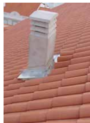
Fig. 7: encuentro de un faldón con un shunt.
