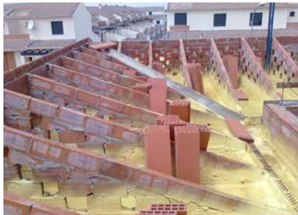
Fig. 8: ejecución de una cubierta en donde se aprecia la formación de pendientes, aplicación del aislante térmico sobre el forjado, así como realización de una limahoya y del canalón.
