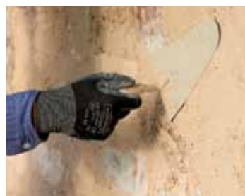
Maison Saint-Vincent-de-Paul à Joigny (89)
