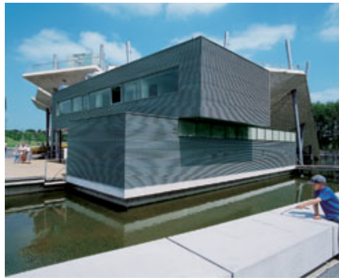
Plataforma sobre el río, Magdeburg (Alemania)
