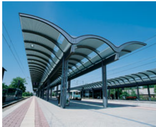
Estación de tren, Salzwedel (Alemania)
